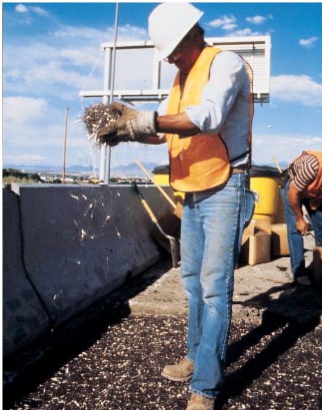
Fig. 7-4. Haces de fibras de acero se ponen en la cimbra (encofrado), antes que la pasta de cemento se derrame en esta aplicación de concreto con fibras de acero impregnadas por lechada. (IMG12409)
