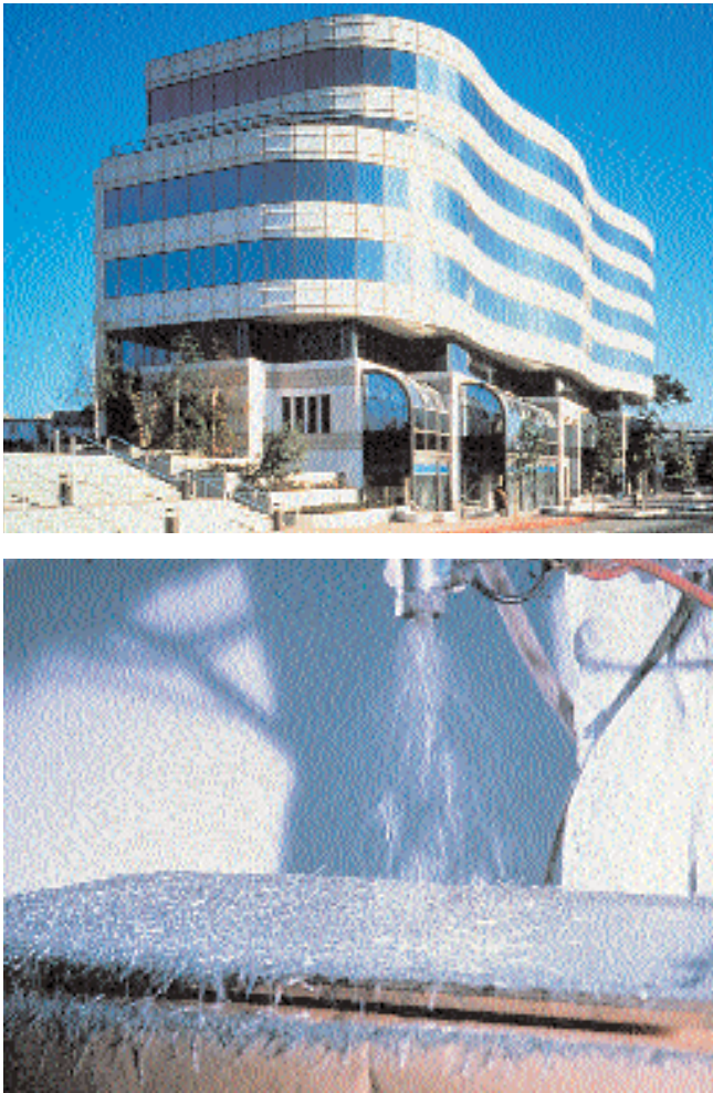
Fig. 7-5. (Superior) Los paneles de concreto reforzado con fibras de vidrio son ligeros y suficientemente fuertes para reducir los requisitos estructurales de este edificio. (Inferior) La fabricación por rociado ha facilitado sus perfiles curvados (IMG12404, IMG12327)
