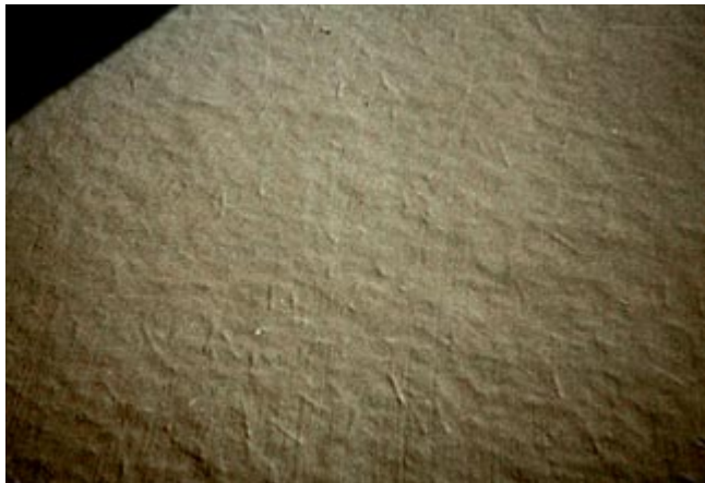
Fig. 7-3. Tablero de puente (cubiertas para puentes) con fibras de acero. (IMG12410)
