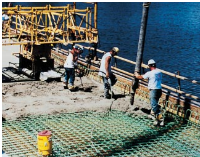
Fig. 6-6. El concreto con baja relación agua-cemento y baja permeabilidad a los cloruros, ideal para el tablero de puentes, se produce fácilmente con reductores de agua de alto rango. (IMG12413)
