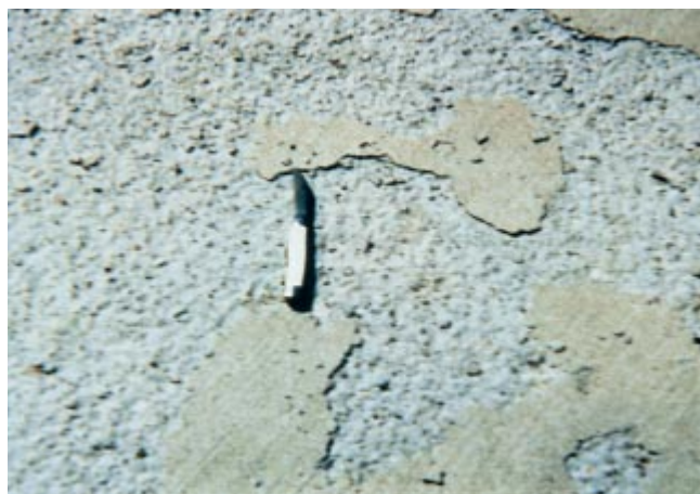
Fig. 6-3. Descascaramiento del concreto resultante de una carencia de aire incorporado, uso de descongelantes y prácticas inadecuadas de acabado y curado. (IMG12414)
