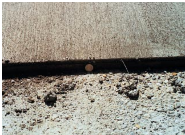
Fig. 6-10. El concreto fluido con plastificantes se coloca fácilmente en secciones delgadas, tales como este revestimiento unido que no es más espeso que 1½ diámetro de una moneda de cuarto de dólar (aproximadamente 4 cm). (IMG12207)
