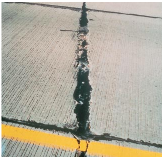
Fig. 6-3. Descascaramiento del concreto resultante de una carencia de aire incorporado, uso de descongelantes y prácticas inadecuadas de acabado y curado. (IMG12414)
