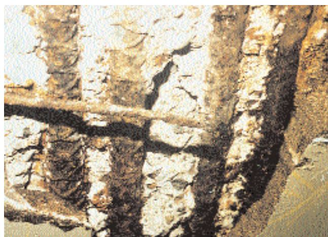
Fig. 6-16. Los daños en esta estructura de estacionamiento en concreto son resultado de la corrosión de la armadura, inducida por cloruros. (IMG12322)
