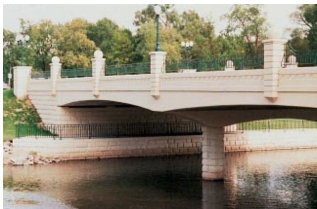
Fig. 3-9. A pesar de que el humo de sílice y la metacaolinita se indican para el uso de construcciones en general, normalmente estos materiales se emplean en aplicaciones tales como (izquierda) puentes y (derecha) garajes con la intención de disminuirse la penetración de cloruros en el concreto. (IMG12427, IMG12426)
