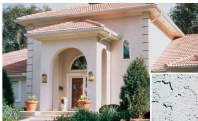
Fig. 2-21. El cemento de albañilería y el cemento plástico se usan para la producción de revoques o estucos para edificios comerciales, institucionales y residenciales. Las fotos enseñan una Iglesia y una casa con estuco exterior. La foto menor, a la derecha, muestra la textura convencional del estuco. (IMG12470, IMG12469, 68805)
