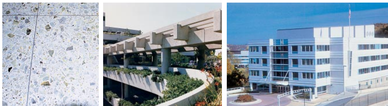
Fig. 2-18. El cemento portland blanco se utiliza en concreto arquitectónico blanco o de colores claros, variando de (de la izquierda para la derecha) terrazas para pisos, enseñado aquí con cemento blanco y agregado de granito verde (IMG12475), para miembros decorativos estructurales premoldeados o moldeados en obra (68981), para el exterior de los edificios. La foto de la derecha muestra el edificio en concreto premoldeado blanco de la sede de la ASTM en West Conshohocken, Pennsylvania. La foto es cortesía de la ASTM.
