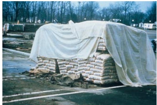
Fig. 2-54. Cuando almacenado en la obra, el cemento se debe proteger de la humedad. (IMG12438)
