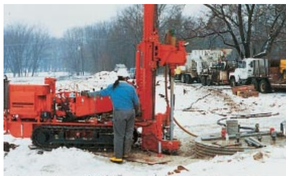
Fig. 2-22. (izquierda) La lechada de cemento finamente molido y agua se puede inyectar en el suelo, como se enseña aquí, para la estabilización de los materiales, para garantizarse la resistencia de cimientos (cimentación, fundación, zapata) o para retener químicamente los contaminantes en el suelo. (IMG12468) Ilustración (derecha) de la penetración de la lechada (groute) en el suelo.
