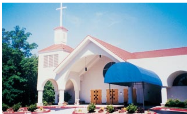
Fig. 2-21. El cemento de albañilería y el cemento plástico se usan para la producción de revoques o estucos para edificios comerciales, institucionales y residenciales. Las fotos enseñan una Iglesia y una casa con estuco exterior. La foto menor, a la derecha, muestra la textura convencional del estuco. (IMG12470, IMG12469, 68805)
