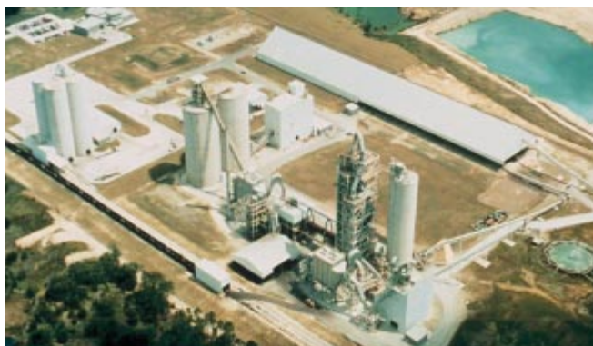
Fig. 2-5. Vista aérea de una planta de cemento. (IMG12442)
