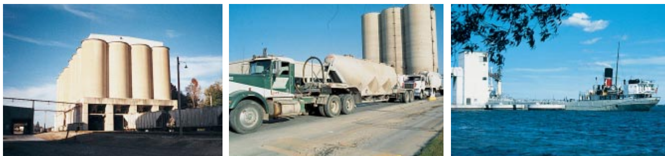
Fig. 2-52. Los cementos portland se despachan a granel de los silos en las plantas para el consumidor por (de la izquierda para la derecha) carril, camión y agua. (IMG12306, IMG12441, IMG12440)
